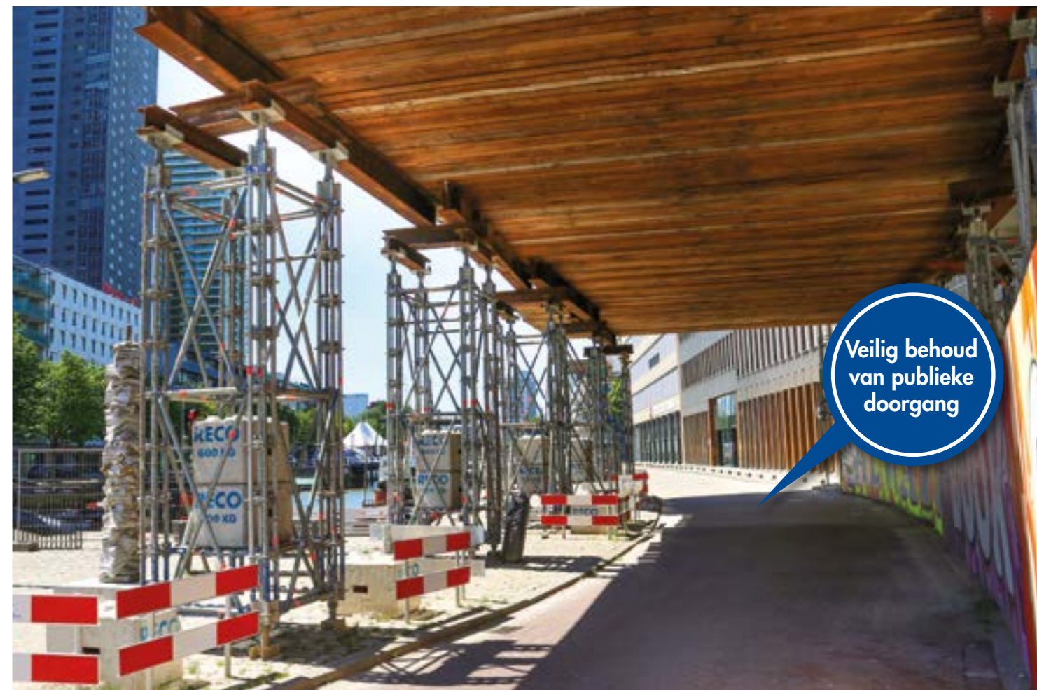
Crashdecks geven u extra opslagruimte en behouden een veilige doorgang voor passanten.
